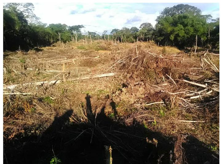
*Sur une superficie de 1500/60m, les travaux d'aménagement de la piste de Watsikengo sont à l'étape de défrichage et dessouchage avant le remblaiement*
